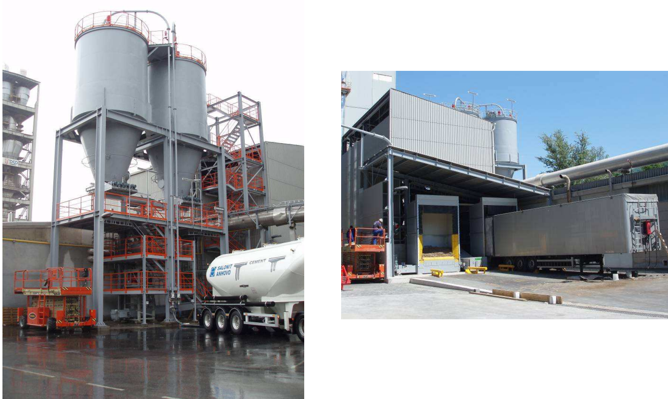
Slika 5: Naprave za skladiščenje in doziranje trdih alternativnih goriv na gorilnik peči
